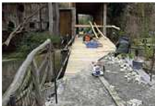
oprava lávky u gibbonů
