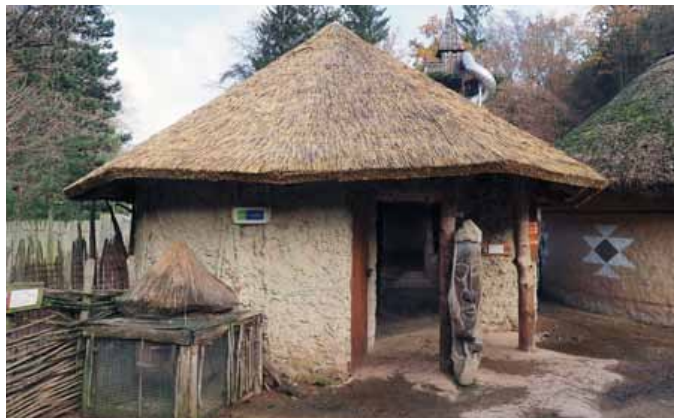
výměna rákosové krytiny na objektu pro kozy kamerunské
