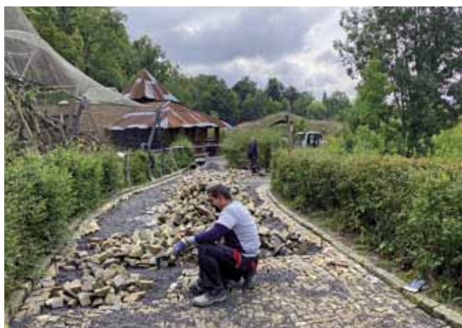
pokládka kamenných odseků na chodníku k pavilonu žiraf
