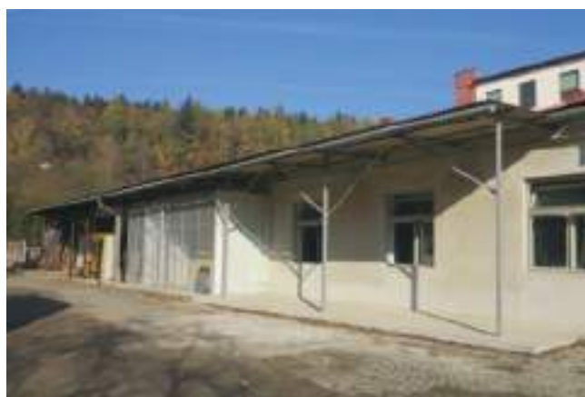
Zrenovovaná část objektu továrny Modeta
