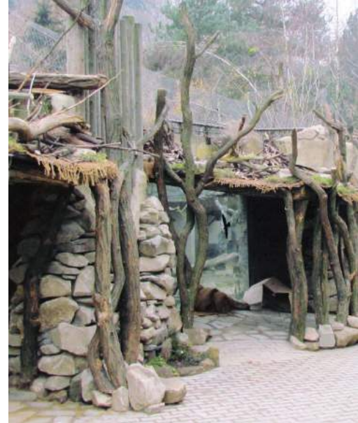
Dodavatelys byla provedena úprava pavilonu pro levharty.
