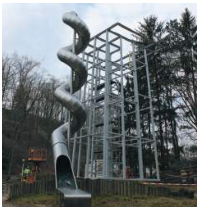
Rekonstrukce věže tobogánu na dětském hřišti
