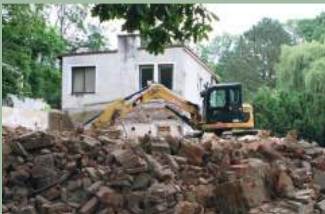
Tropický pavilon – červen 2013 (demolice Exotária)...
